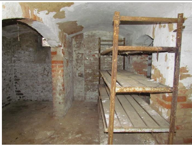
Abb. 12: Blick in den Keller
