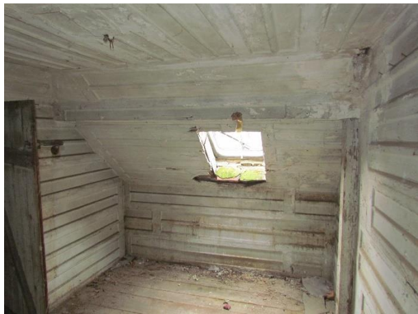
Abb. 10: kleiner Raum im Dachboden
