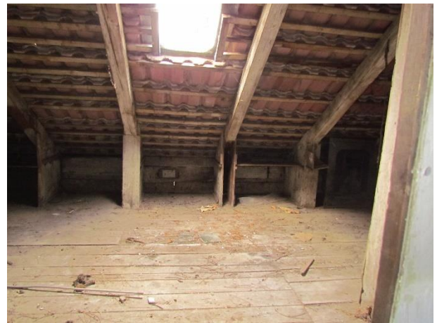
Abb. 11: exemplarisch Ansicht Dachboden
