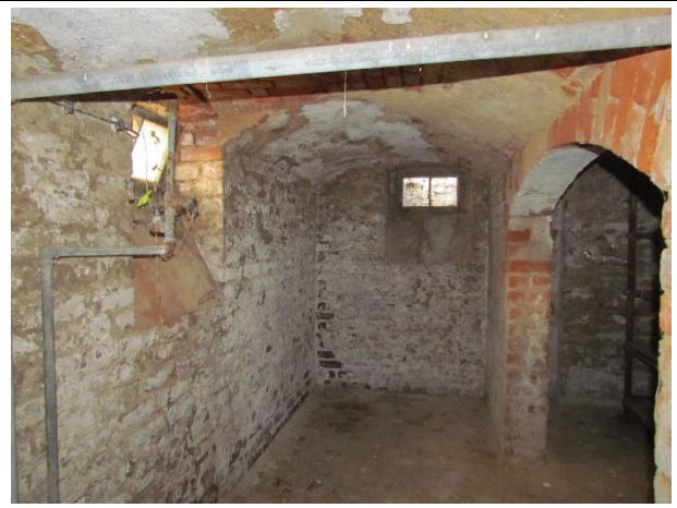
Abb. 13: Blick in den Keller
