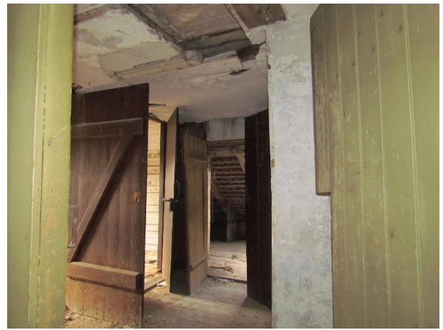
Abb. 9: exemplarische Ansicht Dachbodenbereich
