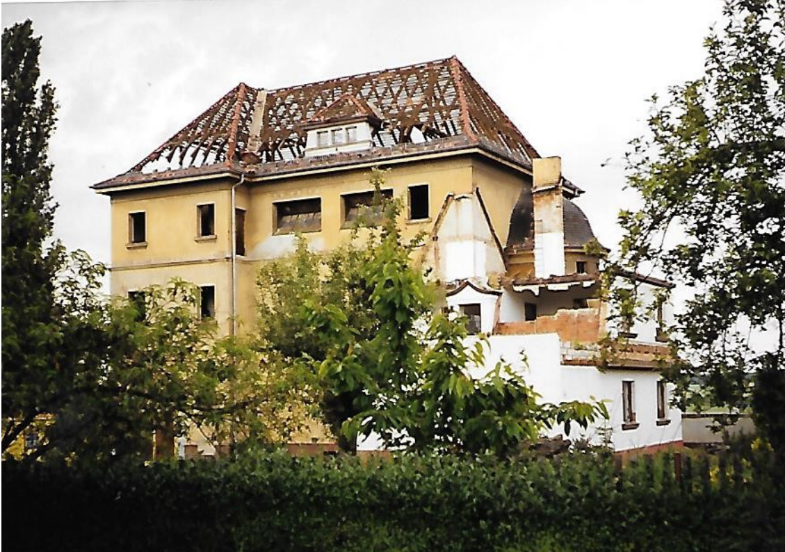
2002: Platz für die Feuerwehr - Das Umspannwerk Wachau wird abgerissen
