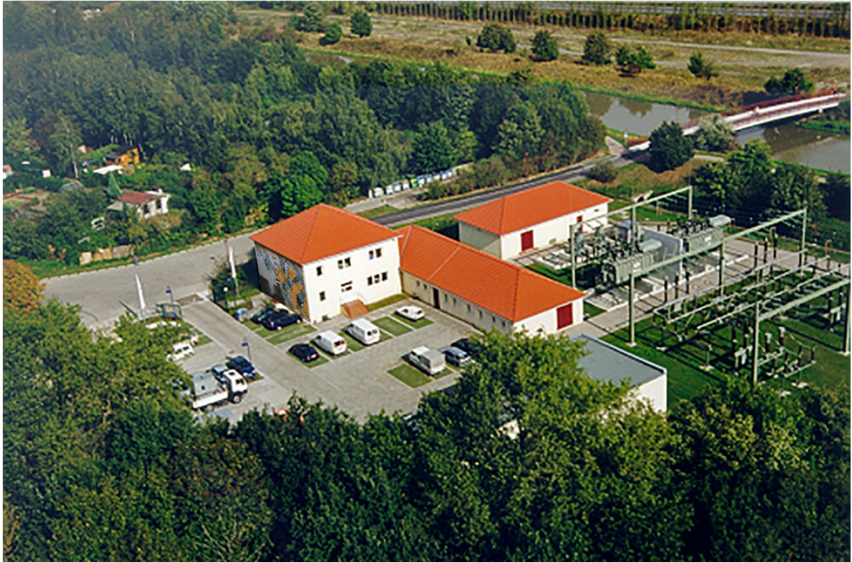
Die elektrotechnische Sammlung und das Umspannwerk Markkleeberg
